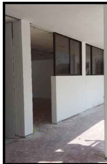
Foto 10. Adecuaciones en la Sede (mayor ventilación y aireación natural)
